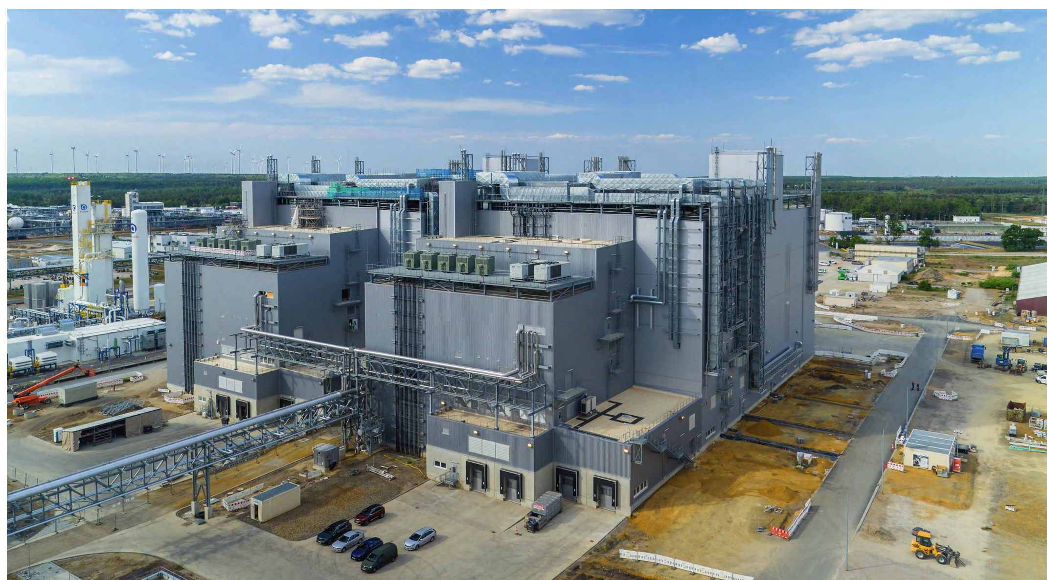
Zakład Produkcji Aktywnych Materiałów Katodowych w Schwarzheide, Niemcy fot. BASF (battery-materials.basf.com)
